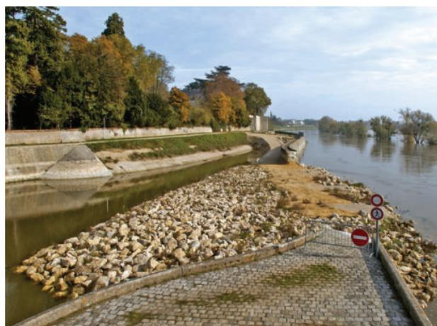
Illustration 4: réparation provisoire par enrochement d'une digue rompue sur la Loire à Chécy (45) © Laurent Mignaux/Terra
