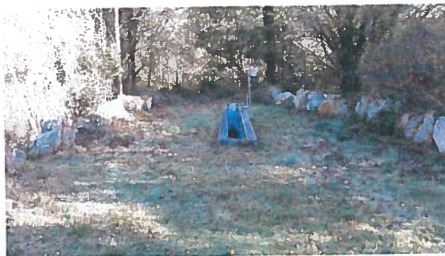
Canal Venturi pour mesure du débit de rejet des eaux dans le Scorff
