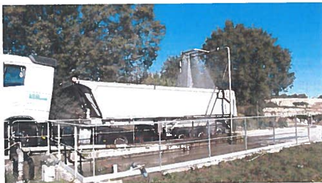
Portique d'arrosage des chargements
