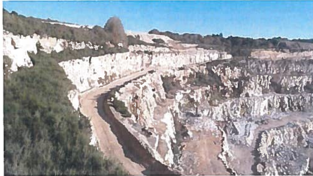
Vue 0 - Vue globale, depuis l'intérieur du site, sur les fronts Ouest actuels où le talutage-remblayage aura lieu
