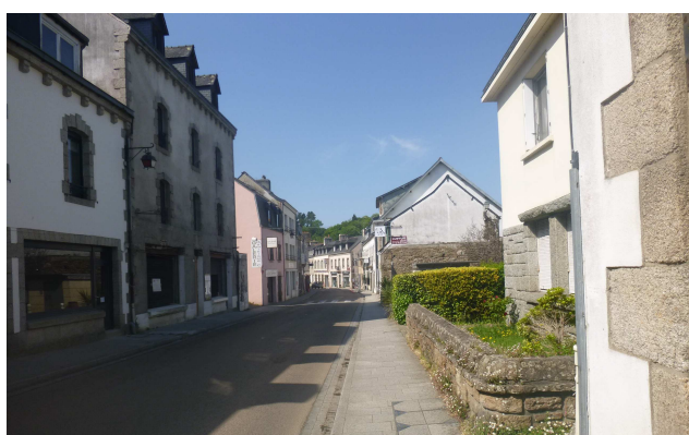
Photo 4 : RD 783, Pont-Aven (© Cerema – 17/05/18)
