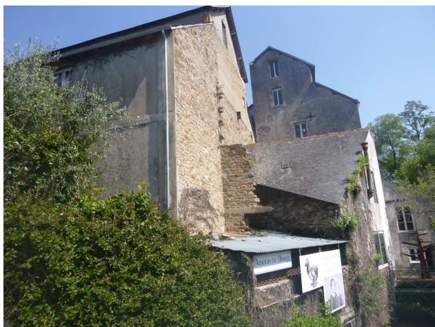
Photo 10 : Minoterie, Pont-Aven (© Cerema – 17/05/18)
