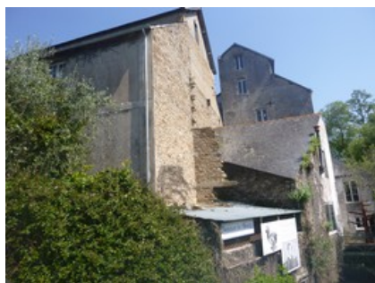
Photo 7 : Minoterie, Pont-Aven (© Cerema - 17/05/18)
