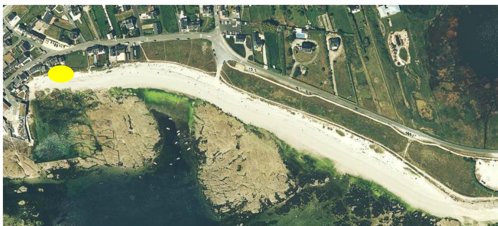
Localisation de la brèche sur le tronçon CD21
