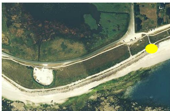
Localisation de la brèche de 100m sur le tronçon SC20
