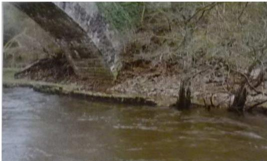
**Photo 28 :** Photographie de JP SALAUN de la crue de janvier 1995 – Dégâts sous le pont de chemin de fer
