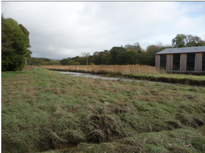
Photo 8 : Limite de la zone d'influence de la mer en amont du moulin de Keridreuff (commune de Pont-Croix)
